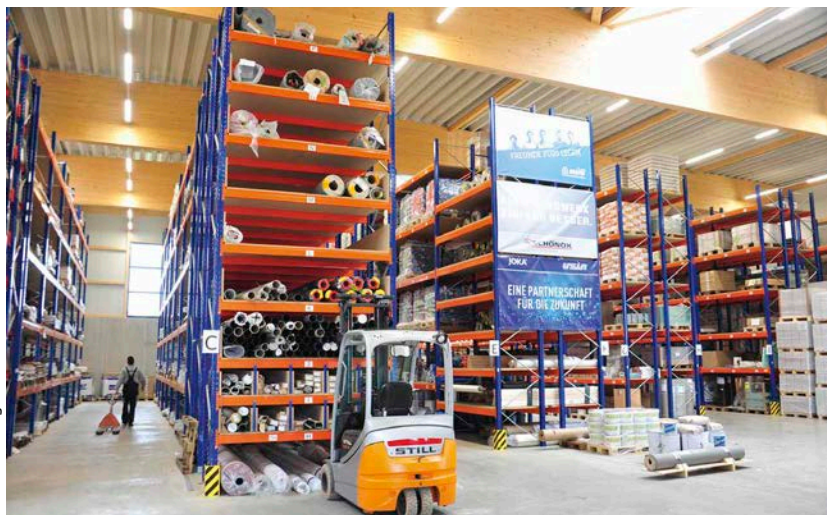
Die 1.800 Quadratmeter große Lagerhalle ist eine Brettschichtholzkonstruktion mit Blechsandwichplatten.
